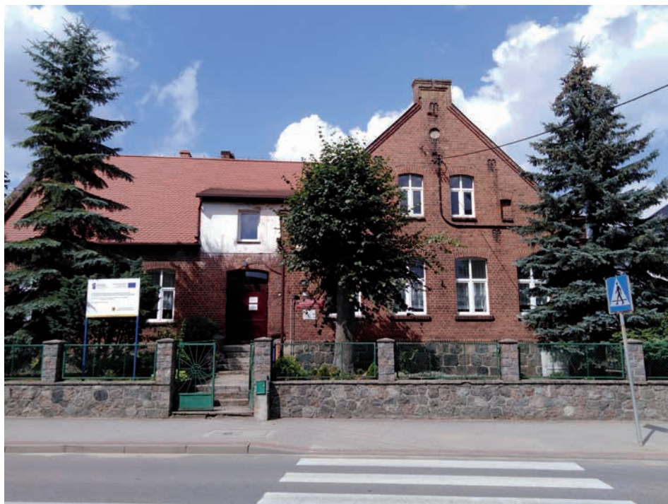
Budynek dawnej szkoły, stan z 2020 roku (fot. K. Kowalkowski)
