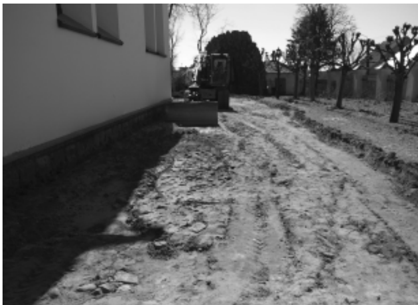
Ryc. 2. Śliwice. Kościół pw. św. Katarzyny Aleksandryjskiej. Widok otoczenia elewacji północnej w trakcie wykonywania prac ziemnych (fot. Marek Kołyszko)
