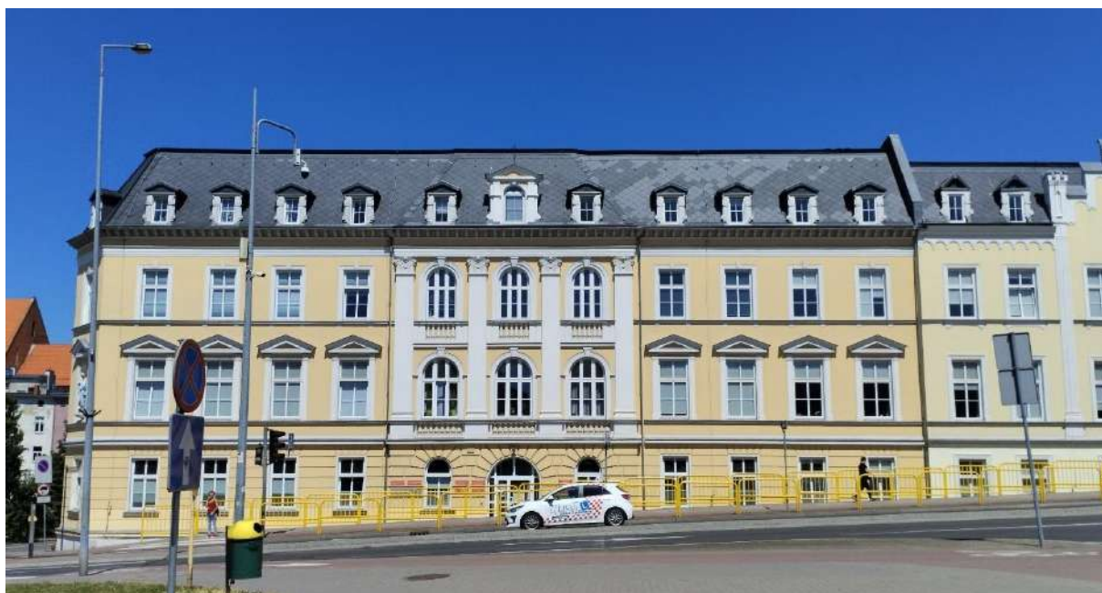
Fot. 1. Budynek, w którym mieści się główna siedziba Miejskiego Ośrodka Pomocy Społecznej w Chojnicach źródło: zbiory własne.
