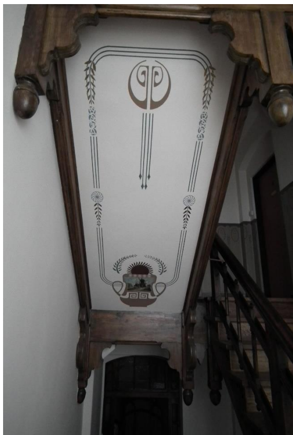
Secesyjna klatka schodowa po pracach konserwatorskich.
