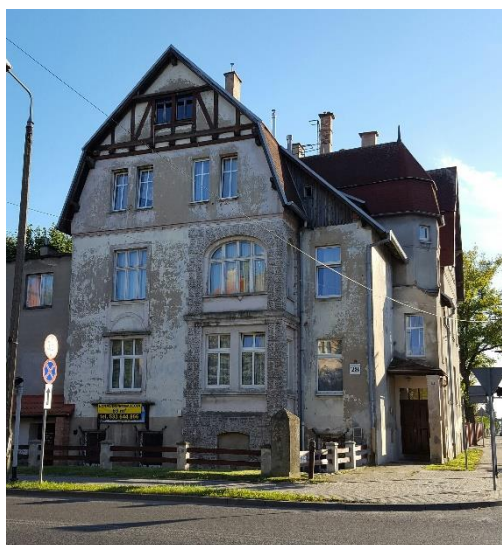
Stan obiektu przed pracami
