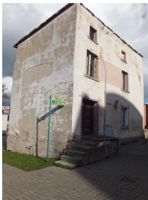
Stan przed konserwacją
