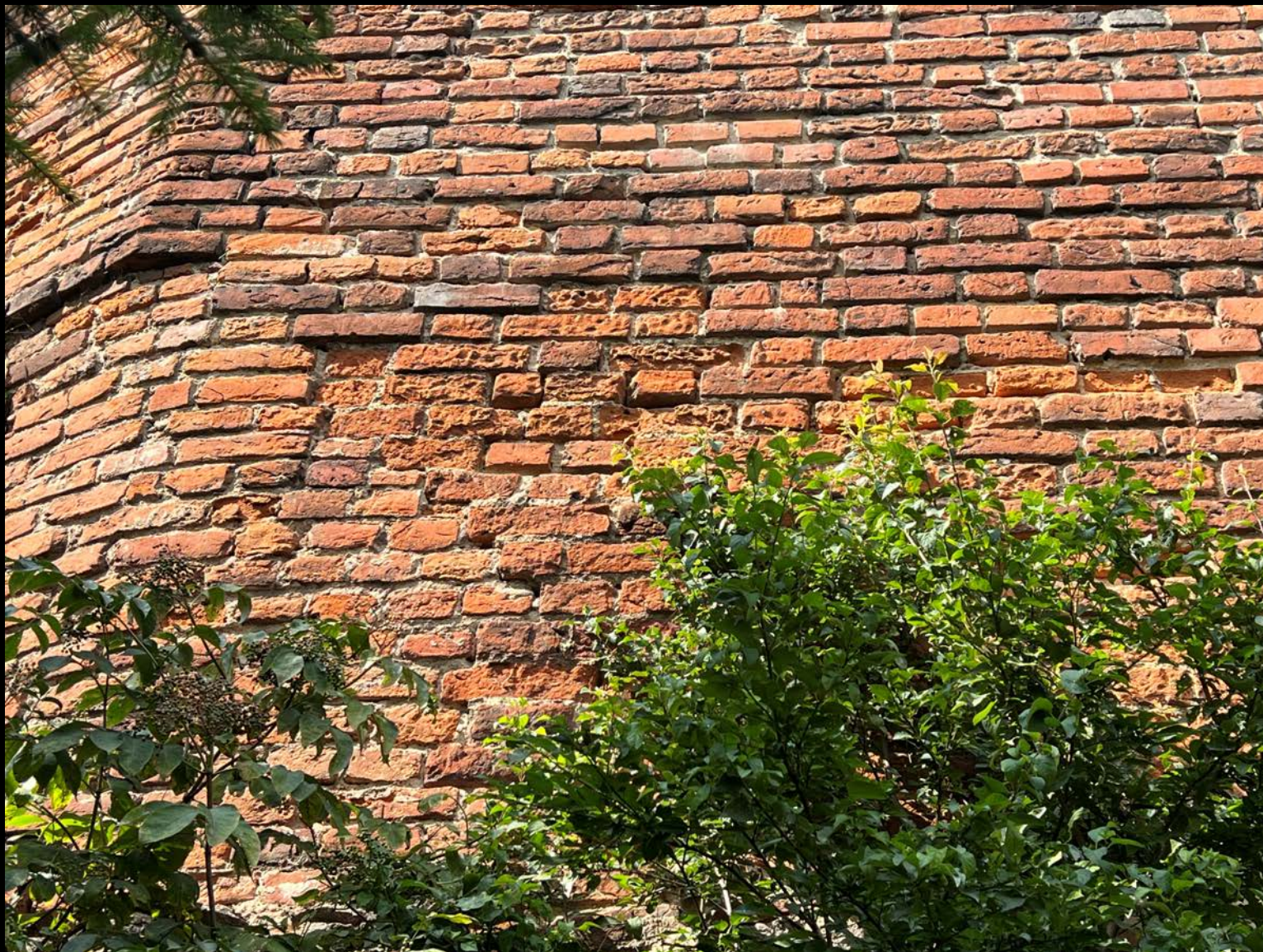
19. Południowa część muru obronnego – korozja mikrobiologiczna cegieł
