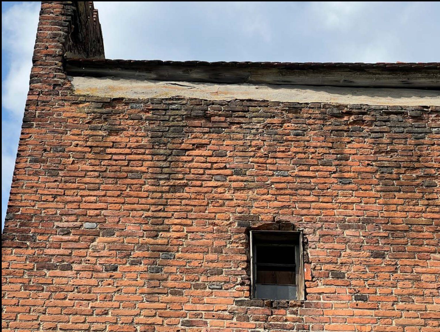
9. Narożnik południowo-wschodni baszty. Przekuty otwór okienny, zabrudzenia wątku, ubytki cegieł.
