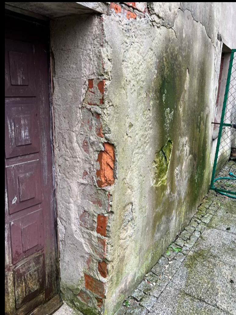
26. Elewacja zachodnia. Ościeże drzwi i porażenie glonami.
