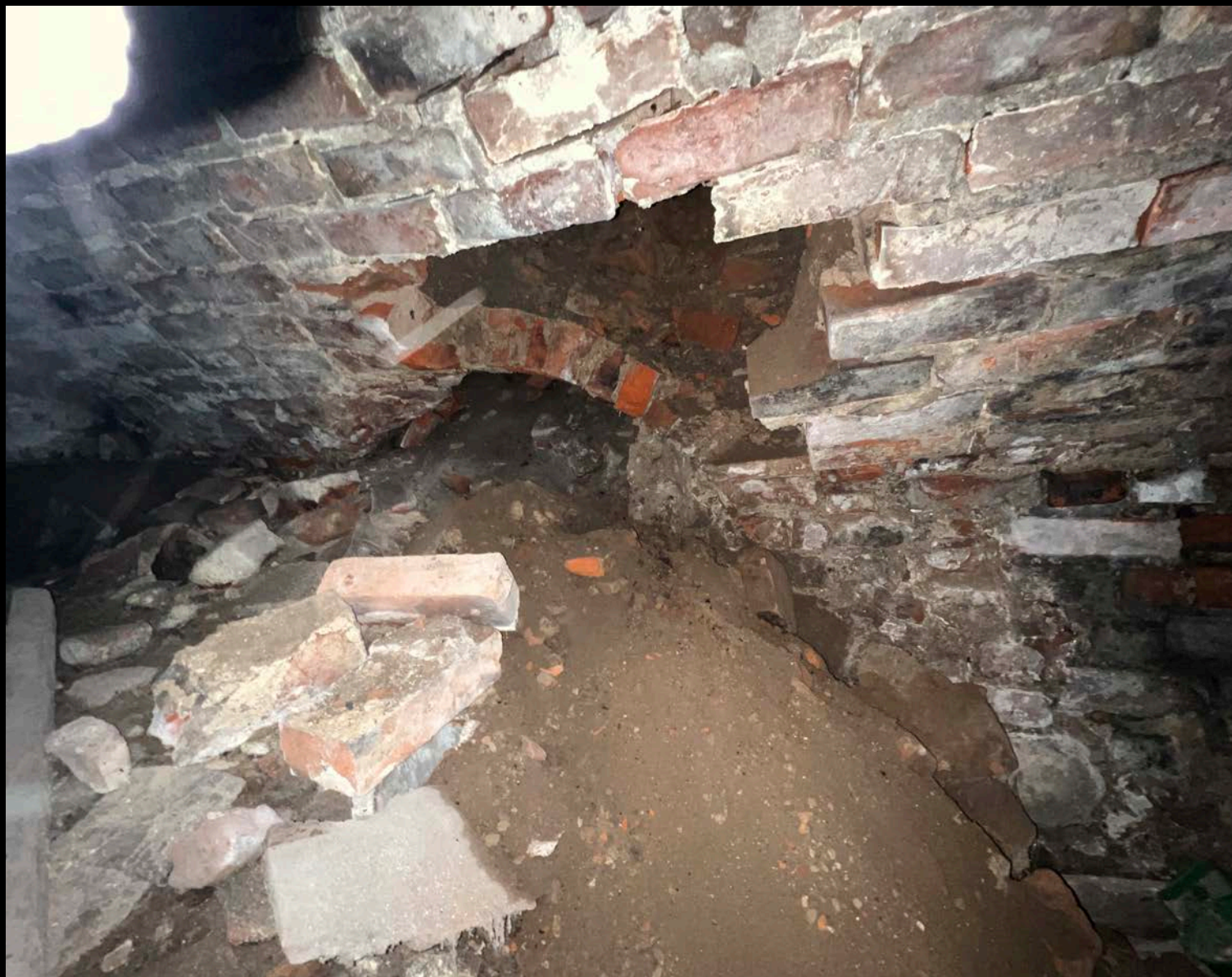
41. Piwnica. Miejsce zawalenia się sklepienia. Widoczny łuk pierwotnego wejścia.
