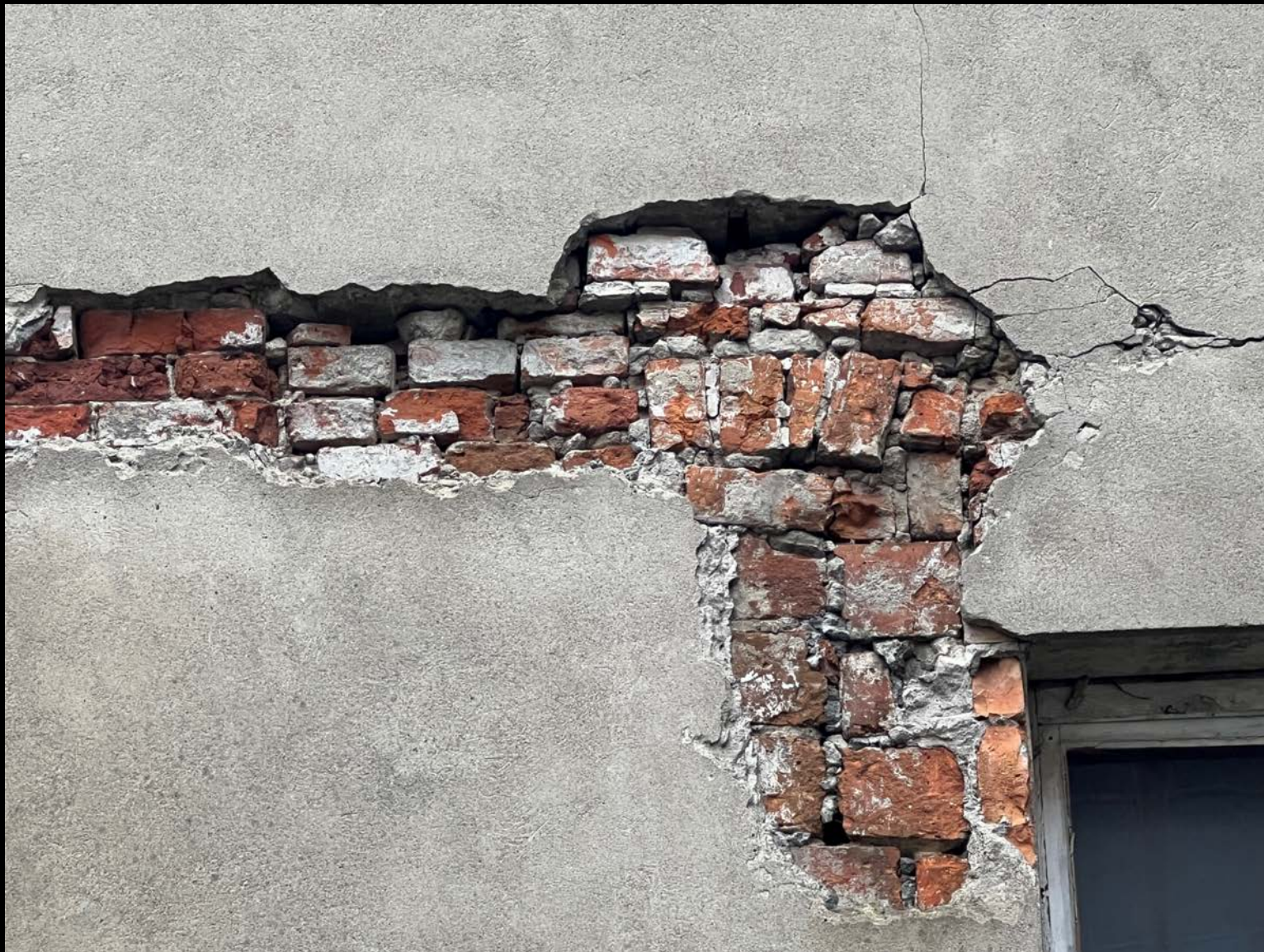
22. Elewacja zachodnia. Przemurowanie w obrębie otworu okiennego.
