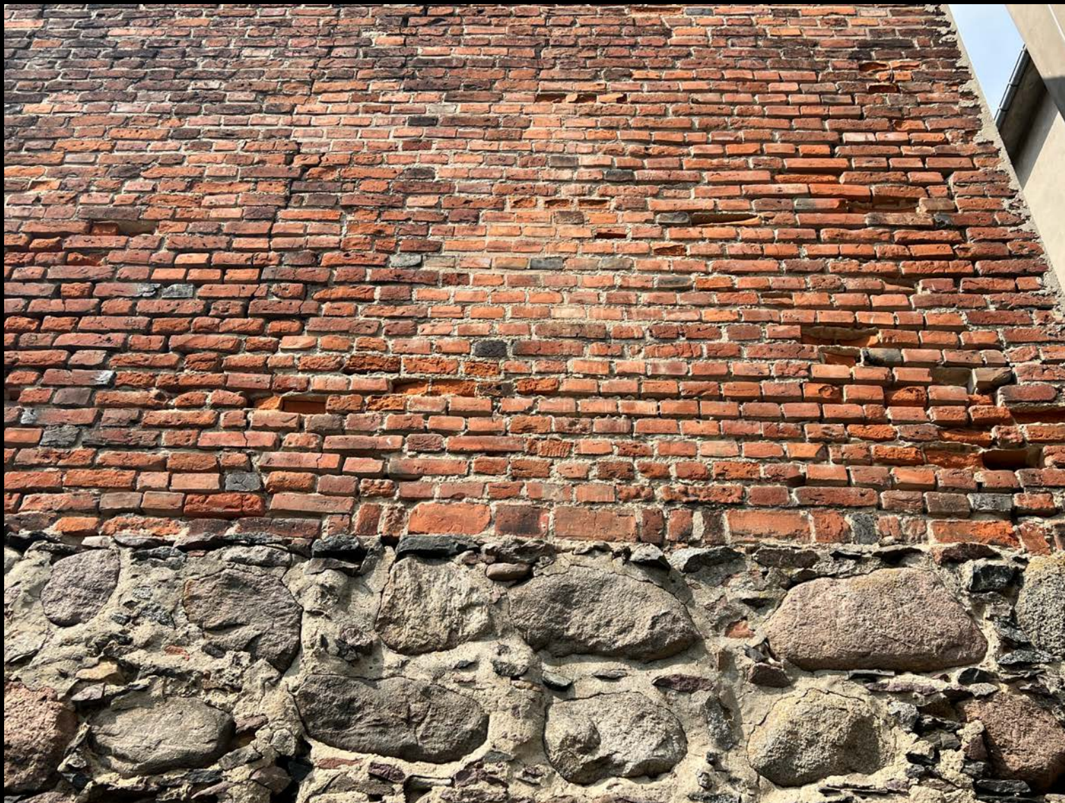
11. Fragment elewacji. Przemurowania cegłą maszynową, ubytki cegieł i spoin.
