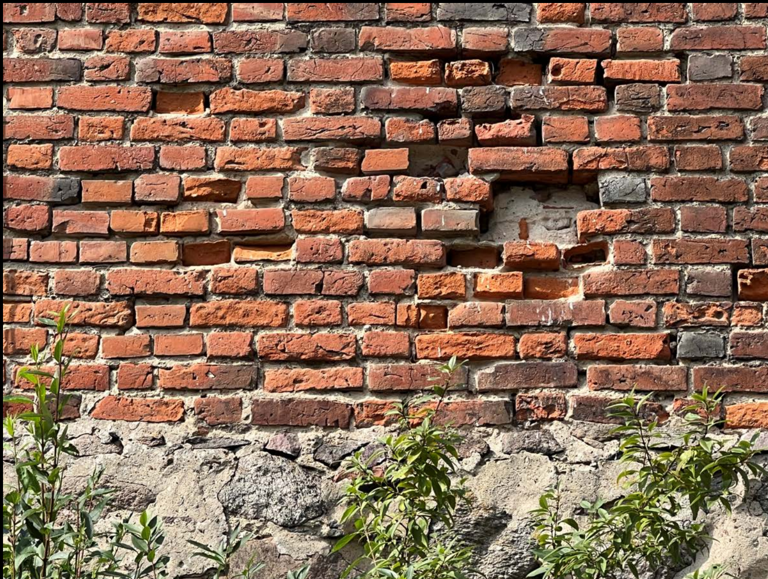
12. Fragment elewacji wschodniej. Ubytki cegieł spowodowane korozją biologiczną.
