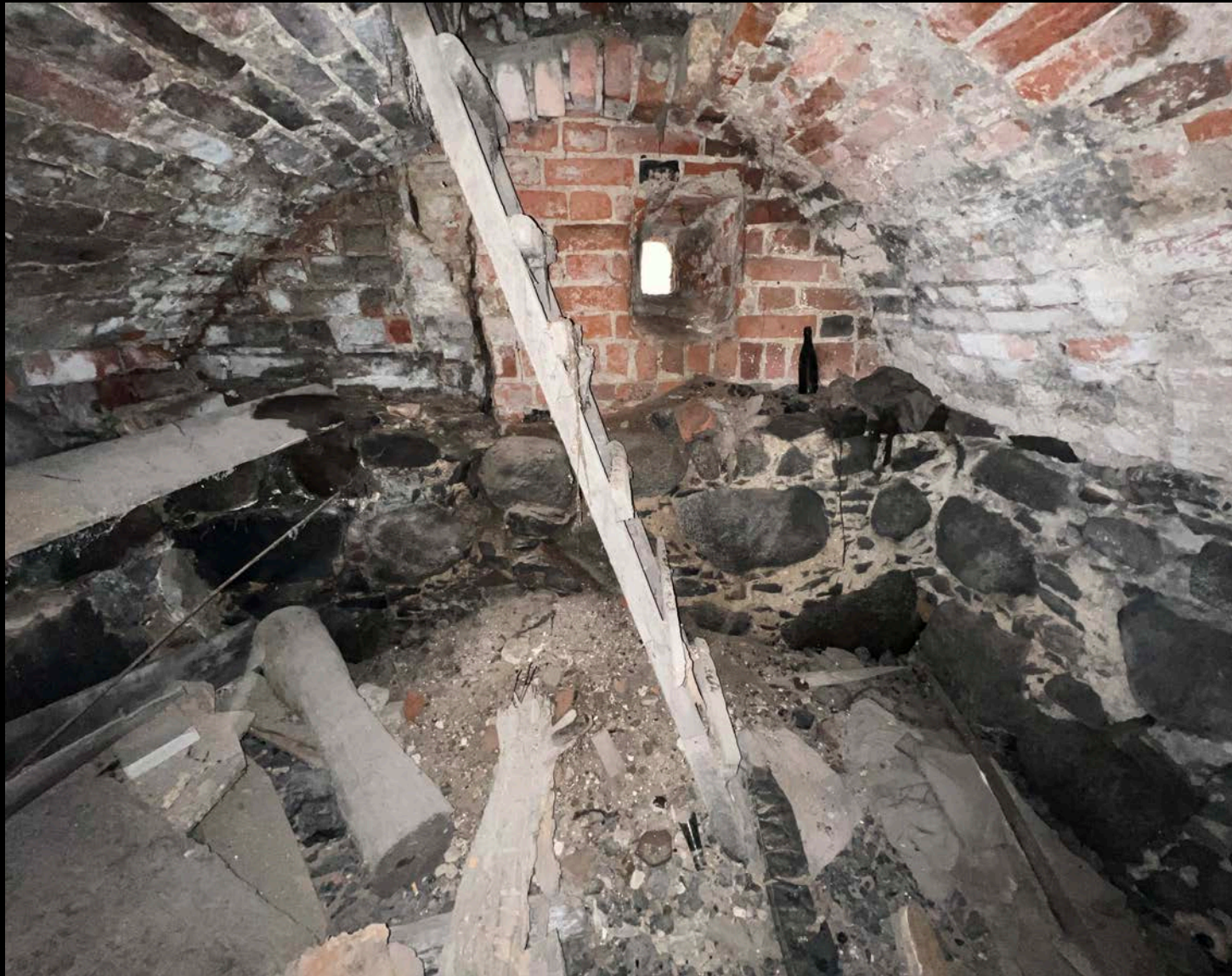
39. Piwnica. Widok na ścianę północną z przekutym oknem i drabiną w wykutym włazie z poziomu parteru.
