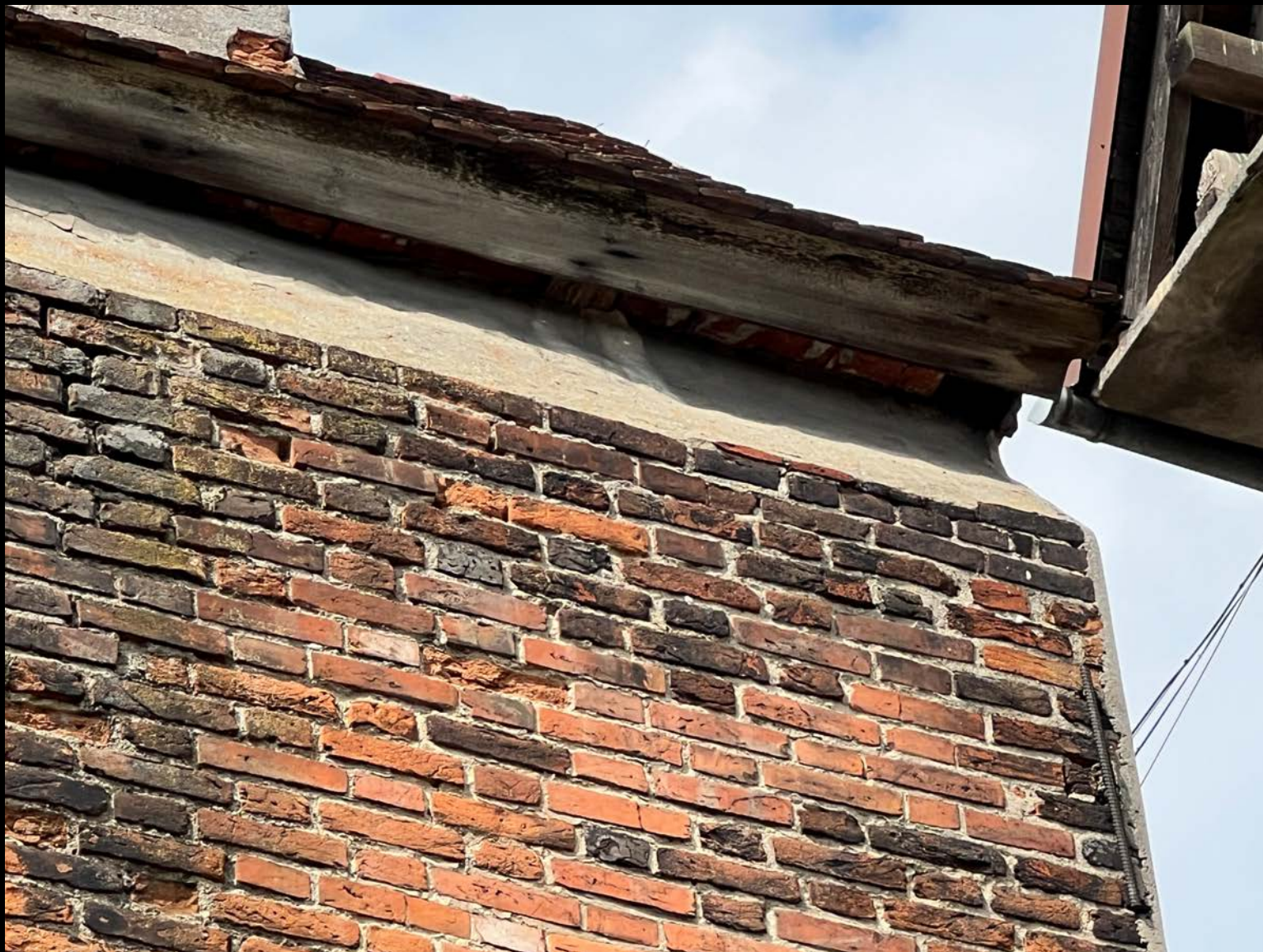
10. Narożnik północno-wschodni. Przemurowania cegłą maszynową, zabrudzenia wątku.
