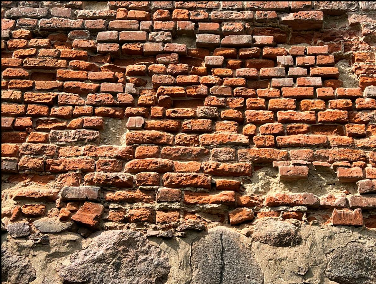
18. Fragment muru obronnego – destrukcja biologiczna cegieł i spoin.
