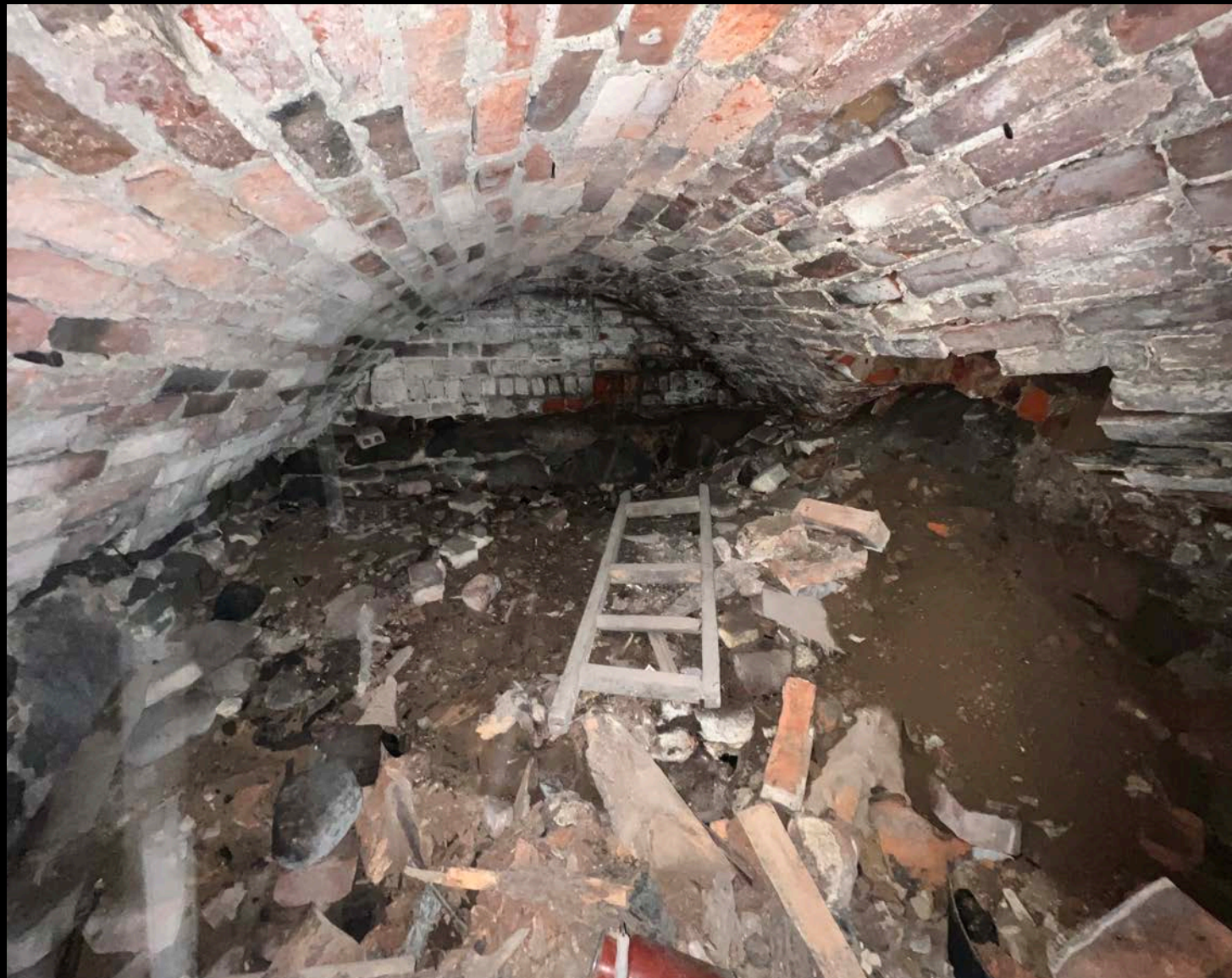
40. Piwnica. Widok na ścianę południową. Z prawej strony widoczne miejsce awarii sklepienia.
