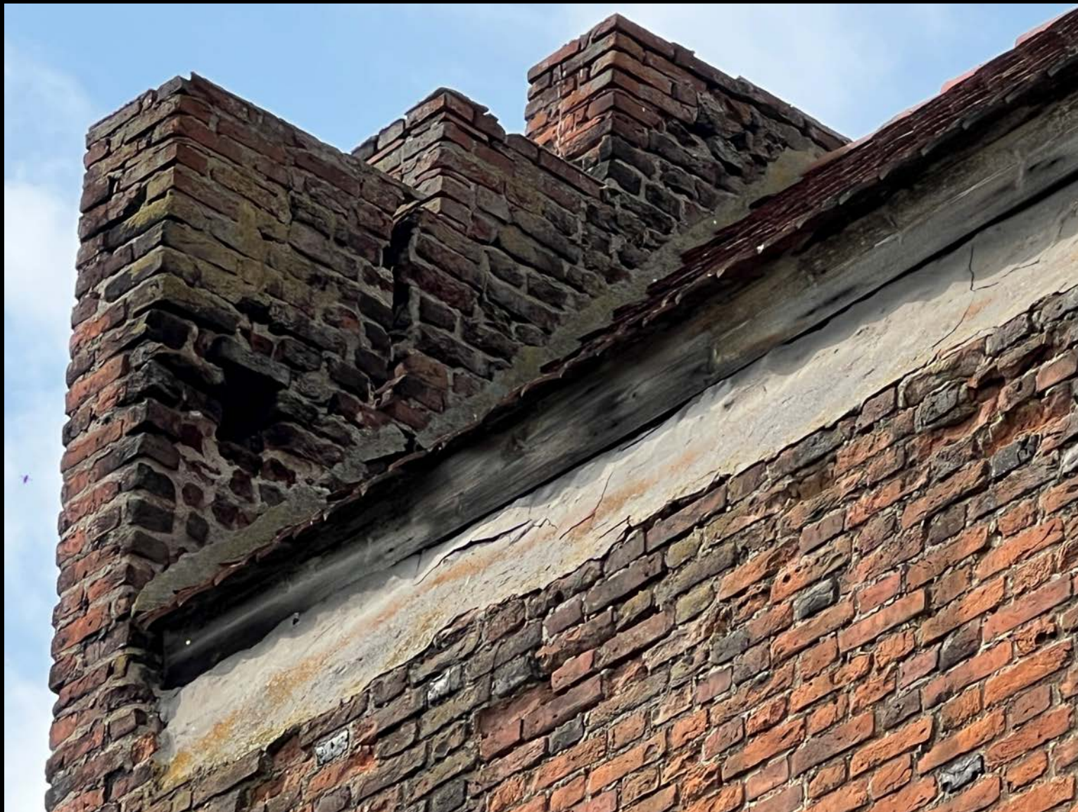
15. Szczyt południowy od strony dachu. Ubytki cegieł i porażenie porostami.
