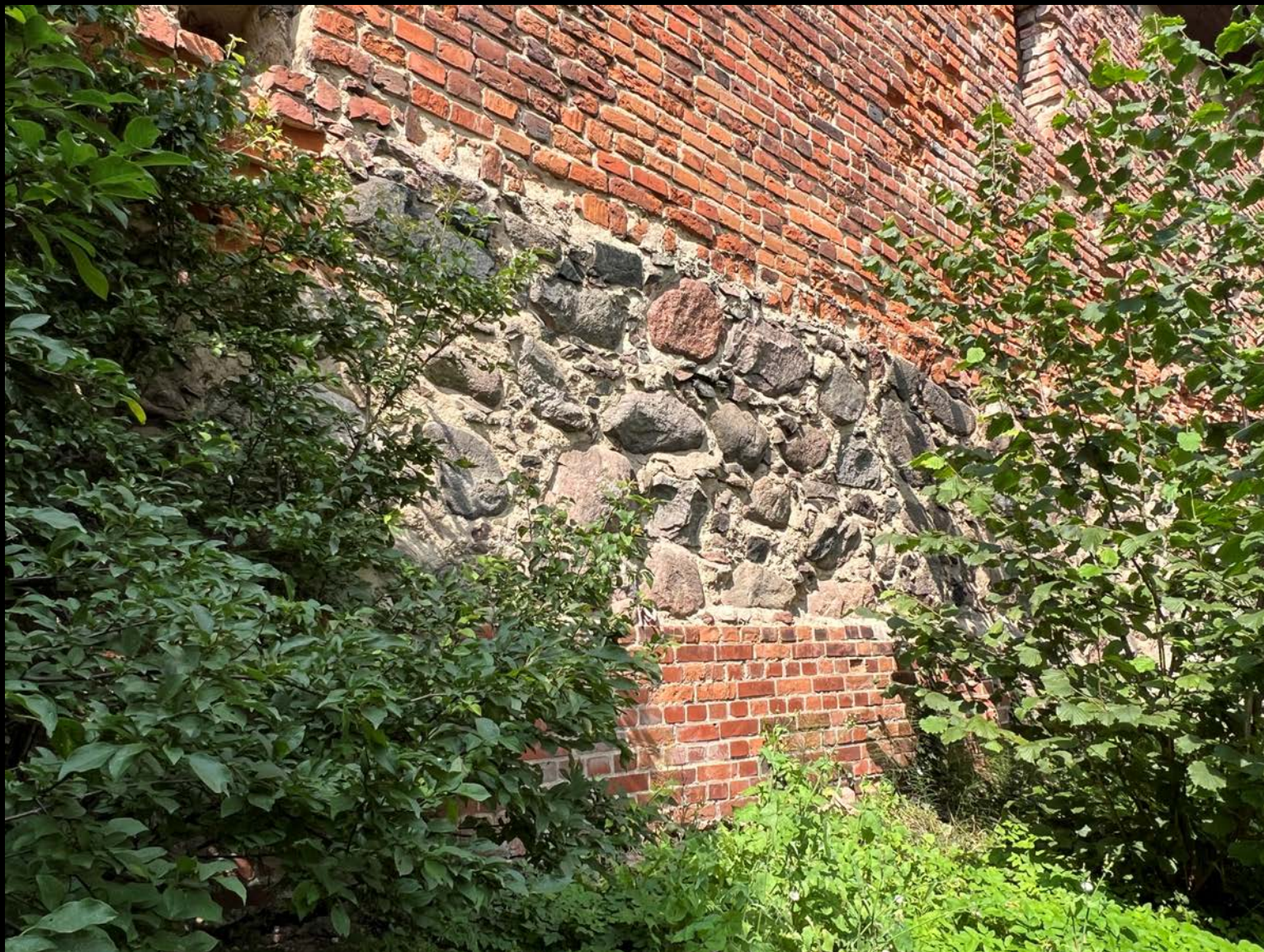
20. Mur obronny – przemurowanie cegła maszynową.
