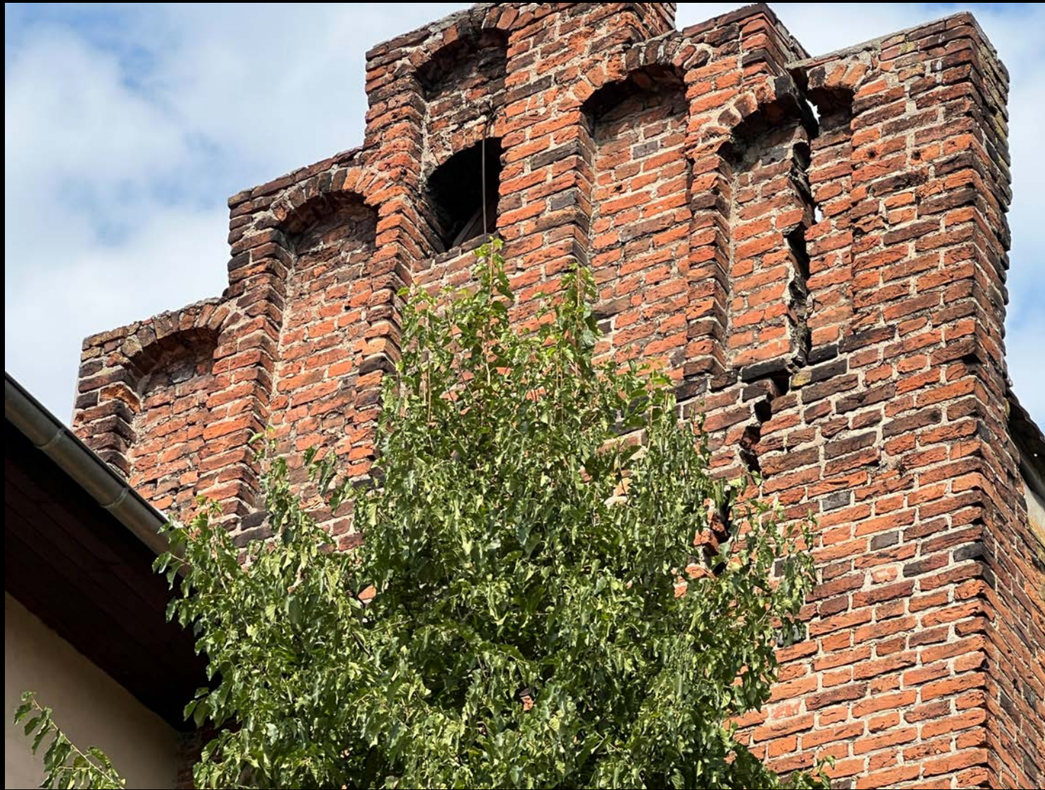
14. Szczyt południowy – widoczne spękanie i przesunięcie muru
