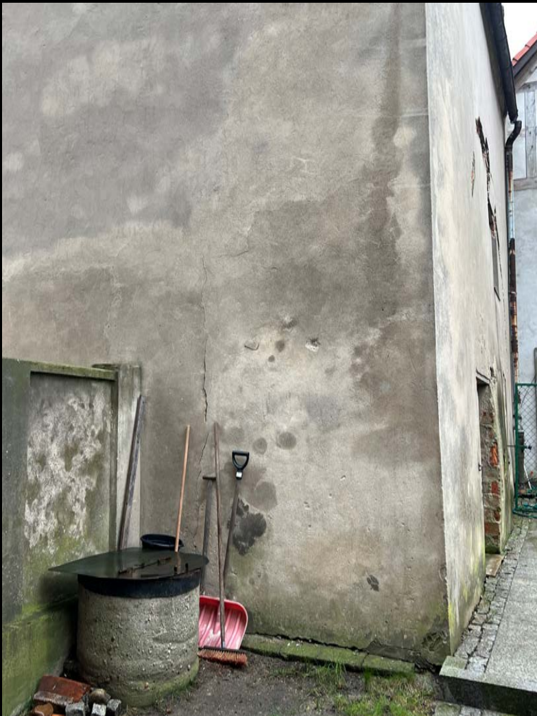
24. Elewacja północna. Zawilgocenie muru
