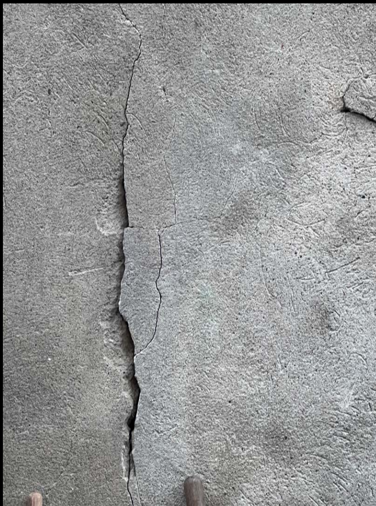
25. Elewacja północna. Spękanie muru.
