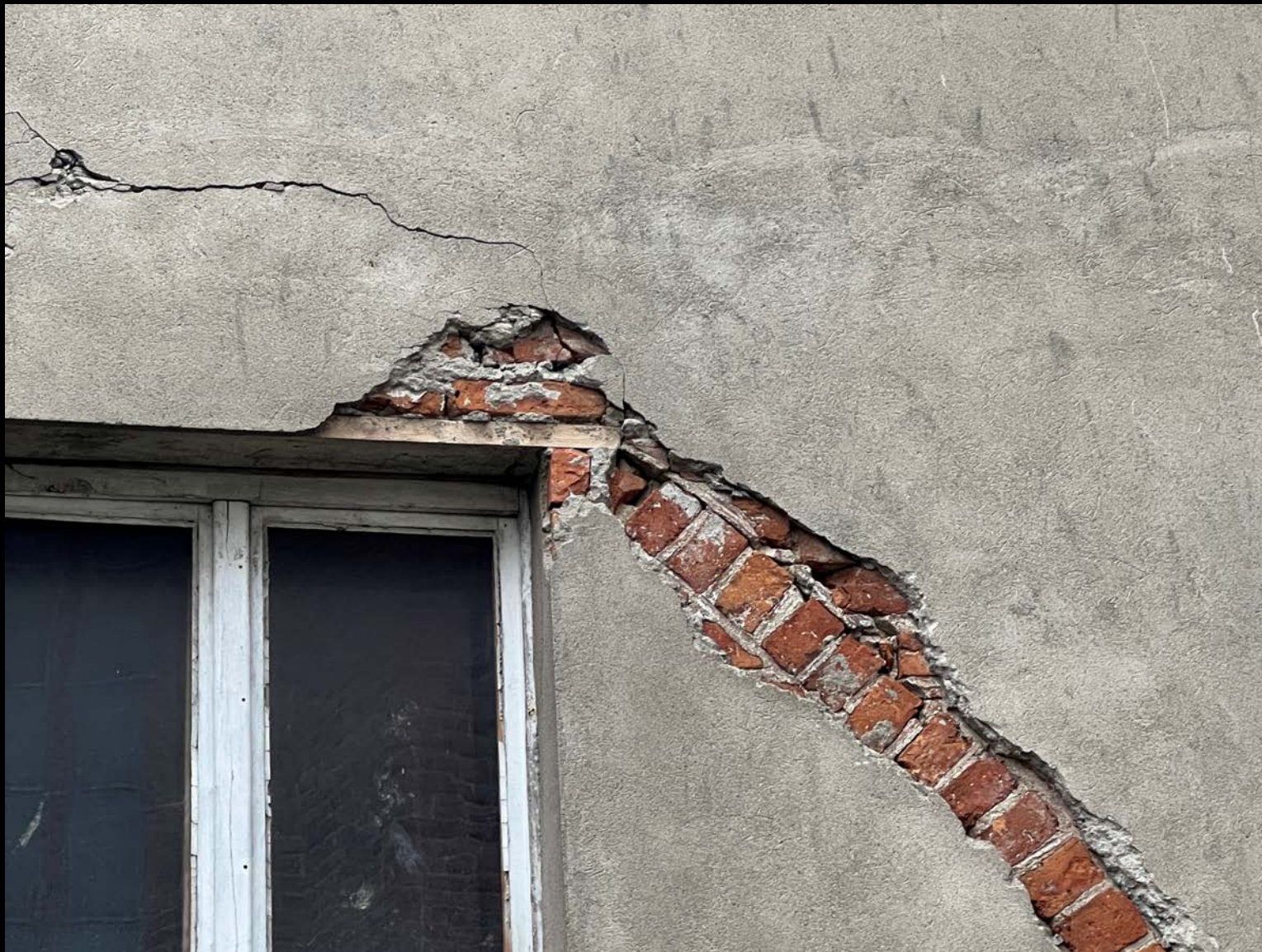
21. Elewacja zachodnia – odsłonięty łęk i przemurowanie nadproża okna
