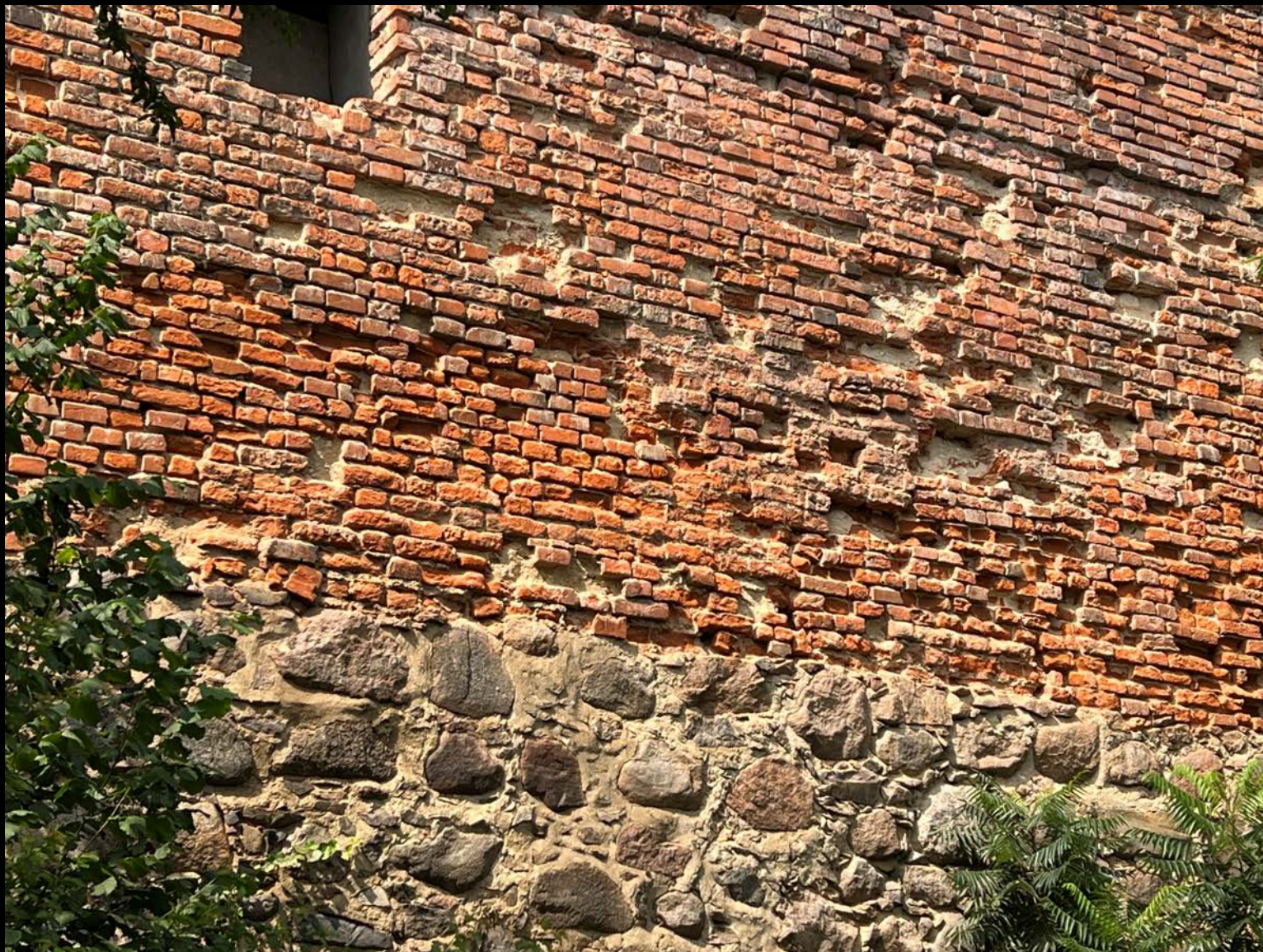
17. Elewacja muru obronnego – ubytki cegieł spowodowane korozją biologiczną.
