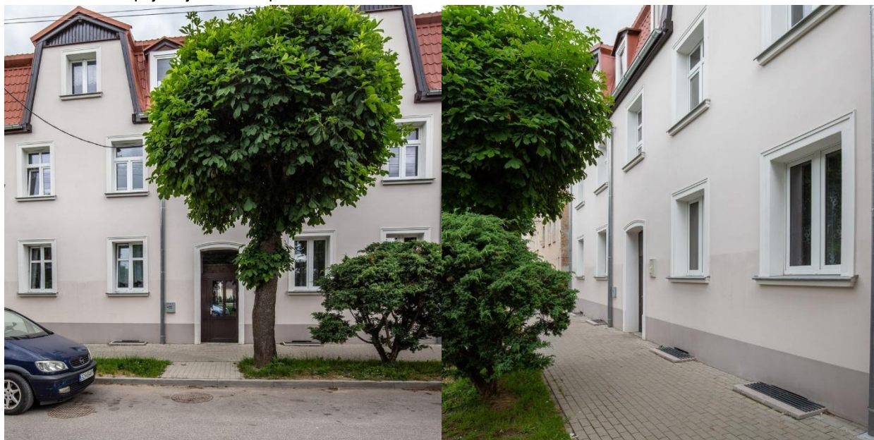
Fot. 4.5. Fotografie inwestycji przy ul. Żwirki i Wigury 11 wykonanej w ramach GPR 2023
