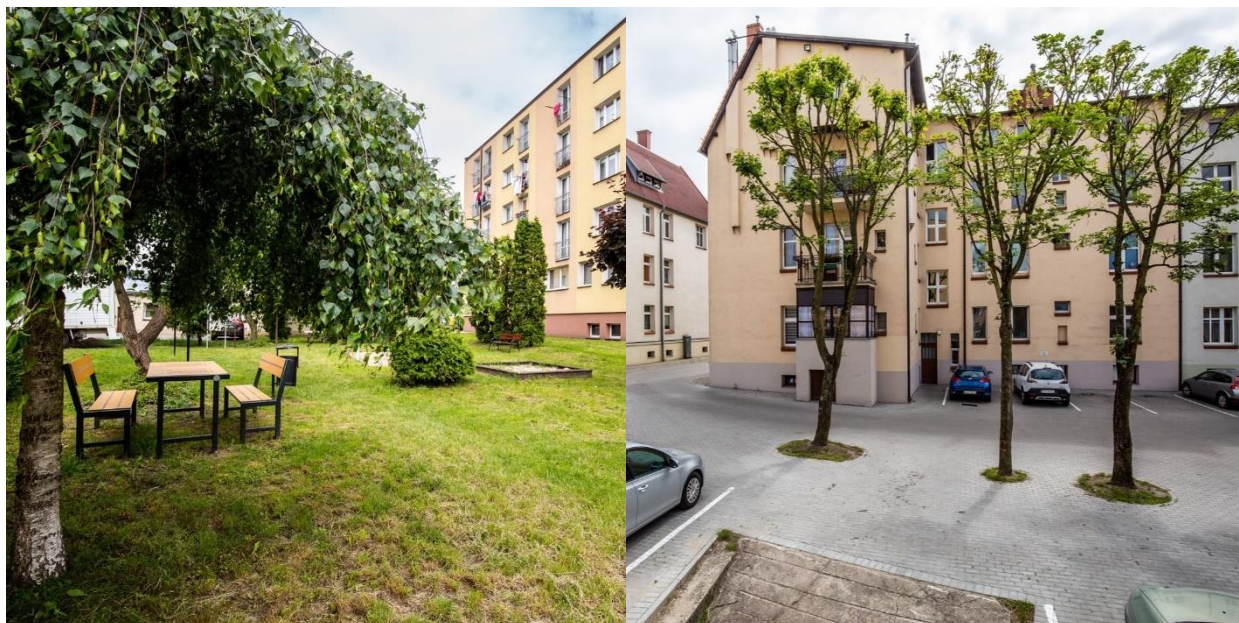
Fot. 4.9. Fotografie inwestycji Spółdzielni Mieszkaniowej w Chojnicach (fragment Drzymały-Łanowa-Warszawska) wykonanej w ramach GPR 2023
