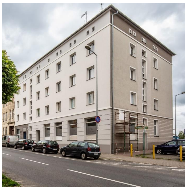
Fot. 4.8. Fotografie inwestycji przy ul. Piłsudskiego 22 wykonanej w ramach GPR 2023
