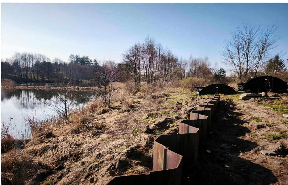
Ścianka szczelna, fot. Urząd Miejski w Chojnicach
