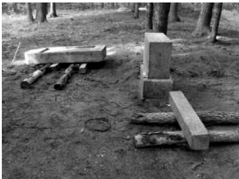
Ryc. 9. Niebędzino, gmina Nowa Wieś Lęborska. Elementy pomnika w trakcie prac montażowych (fot. M. Kołyszko)
